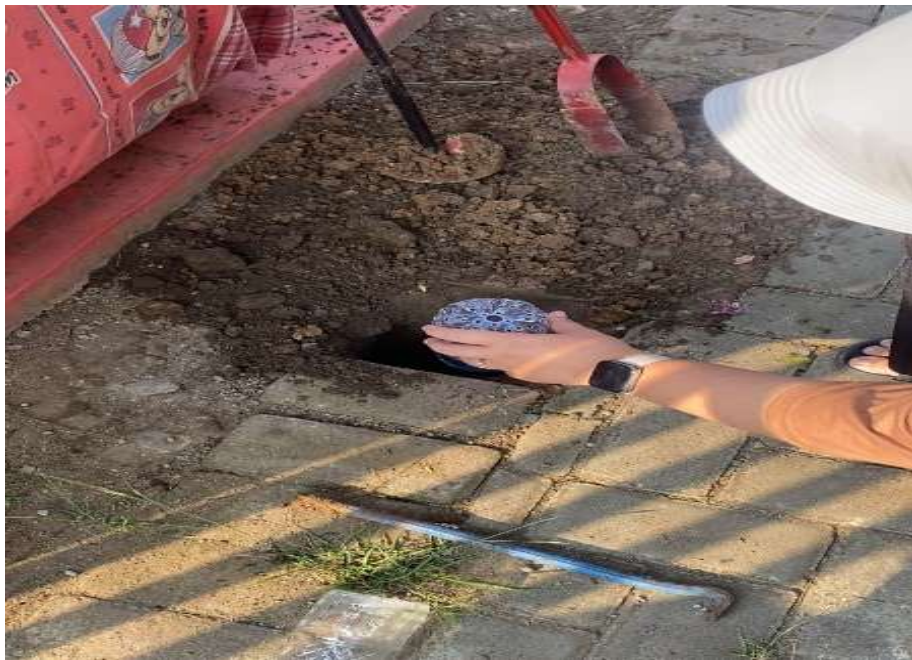
Gambar 5. Pemasangan Biopori pada Bantaran Sungai.
