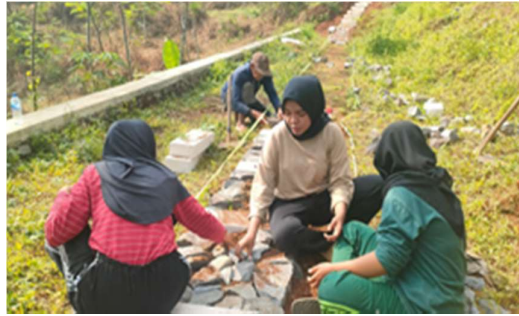
Gambar 6. Pemasangan jalan tapak mini garden
