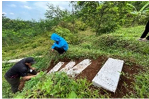
Gambar 4. Pembangunan tangga mini garden
