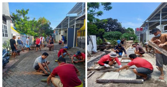
Gambar 5. Pembuatan Penutup Saluran Drainase
