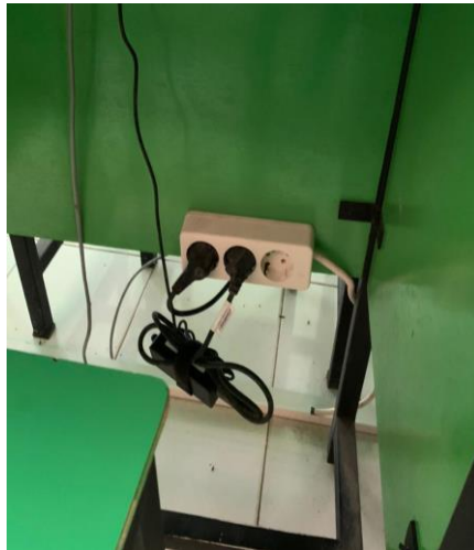
Gambar 6. Pemasangan terminal listrik.
