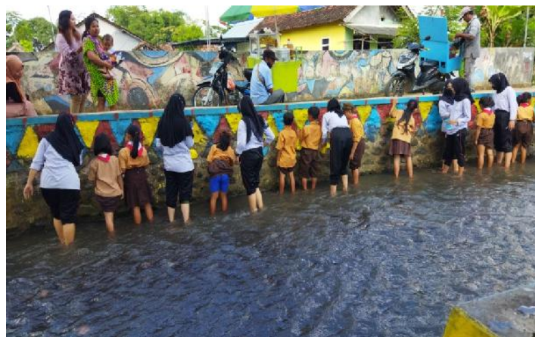
Gambar 4. Pengecatan Plengsengan Sungai
